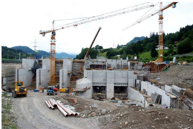
Die Arbeiten am neuen Kraftwerk Werfen/Pfarrwerfen gehen planmäßig voran. Die beiden Generatortraggänge, an denen die Rohrturbinen mit dem Generator verbunden und im Krafthaus befestigt werden, wurden im Sommer ins Krafthaus, das noch nicht ganz fertig gestellt ist, eingebaut. Mit der Montage der Stahlkonstruktion für die Maschinenhalle wurde bereits begonnen. Die Wehrverschlüsse sind eingebaut und werden nun mit den technischen Systemen
